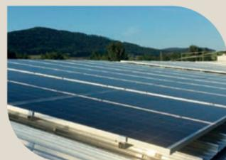
Die 29.12 kWp PV-Anlage auf dem Dach der Caddyhalle leistet einen geschätzten Jahresertrag von ca. 29'000 kWh.
